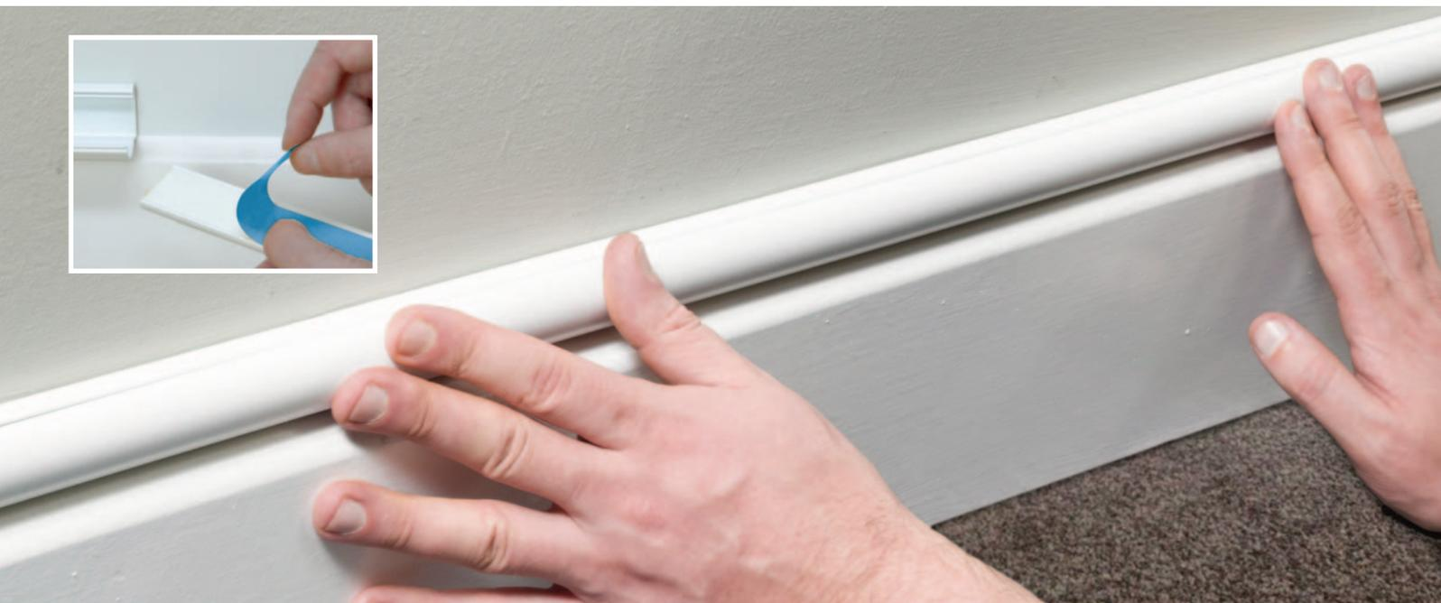
**Vous avez tracé de manière exacte l'agencement de votre dispositif D-Line de dissimulation des câbles, découpé des tronçons à la longueur requise, en faisant appel à une scie à fine lame, prévu de couvrir les vides en employant des coudes ou coins à clipser.**
